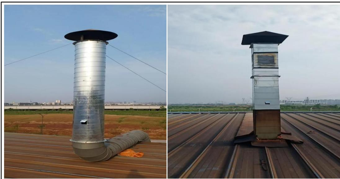
房顶管道等离子切割除尘管道
